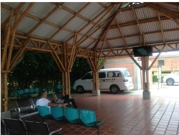
Fotografía 155 Sala de Conductores
