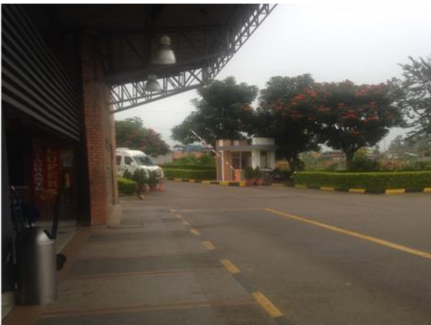
Fotografía 173 Plataforma de Descenso
