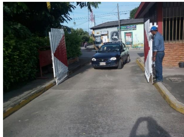
Fotografía 120 Casetas de Ingreso
