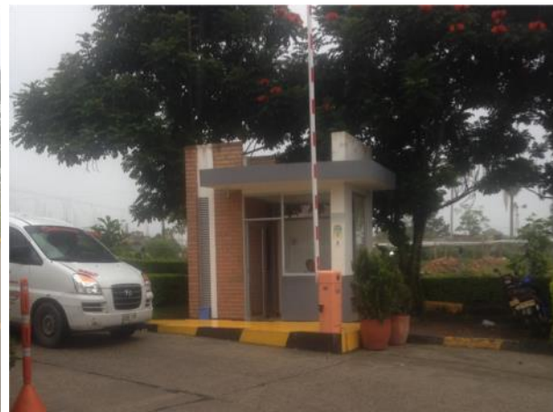
Fotografía 174 Caseta Control de Ingreso
