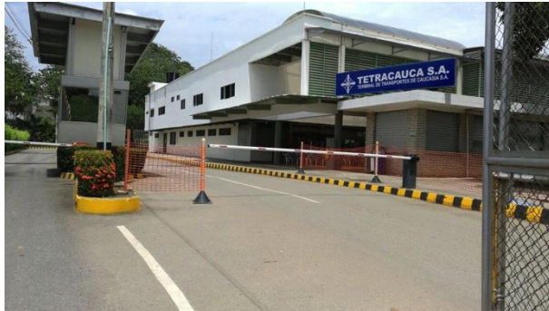
Fotografía 19 Vías de Acceso a Terminal
