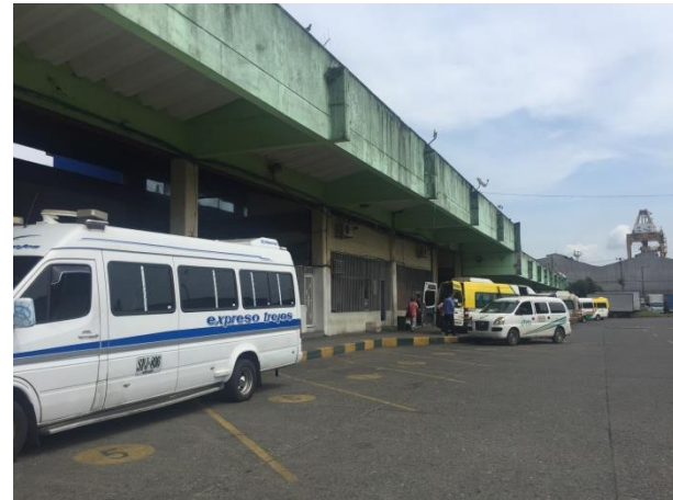
Fotografía 265 Zona de Abordaje
