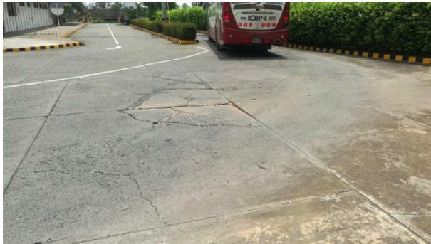
Fotografía 20 Vías Patio Operativo
