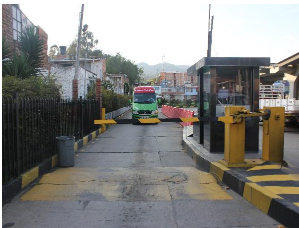
Fotografía 72 Casetas de Control
