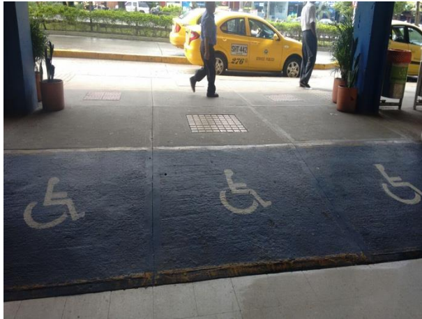
Fotografía 109 Acceso a Termina
