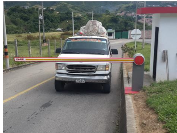
Fotografía 216 Caseta de Control
