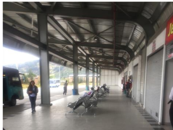
Fotografía 77 Plataforma de Descenso
