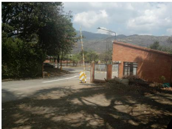
Fotografía 239 Caseta de Control
