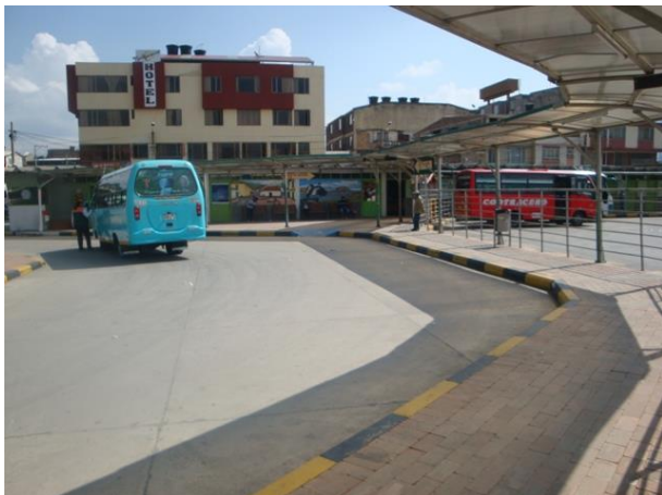
Fotografía 84 Plataforma de Descenso
