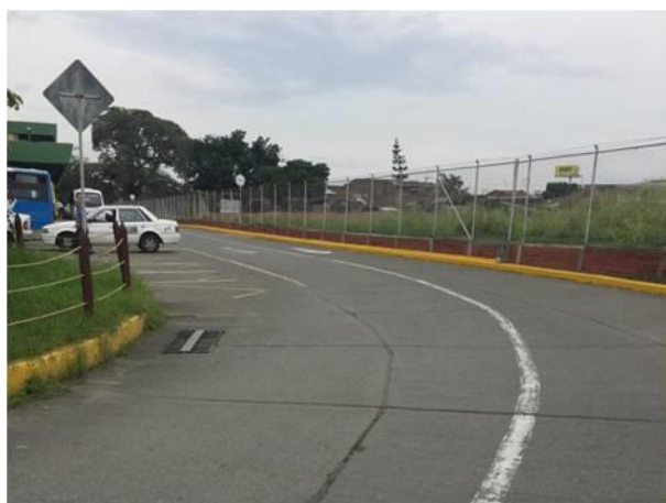
Fotografía 286 Vías de Acceso a Patio Operativo
