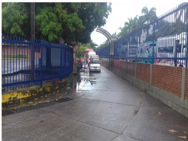
Fotografía 192 Caseta de Control
