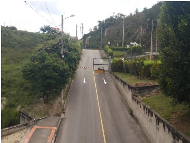
Fotografía 211 Vías de Acceso
