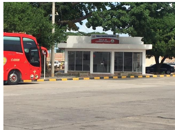
Fotografía 126 Sala de Conductores
