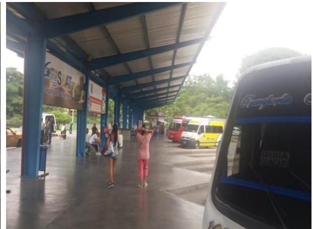
Fotografía 275 Plataforma de Descenso
