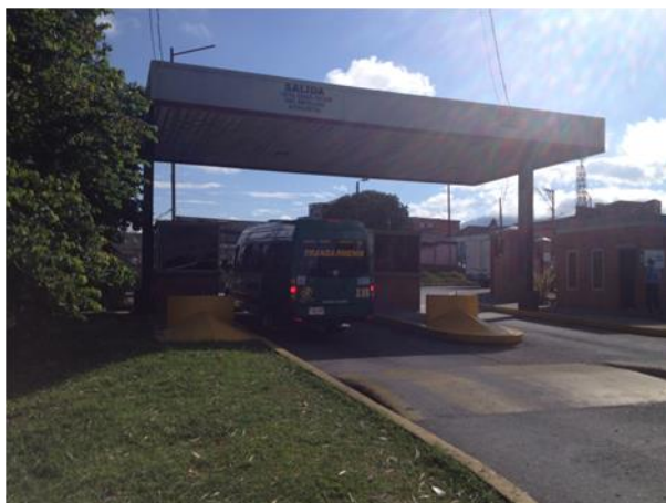
Fotografía 180 Casetas de Control
