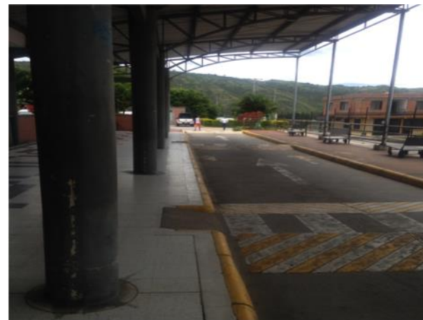
Fotografía 156 Plataforma de Descenso
