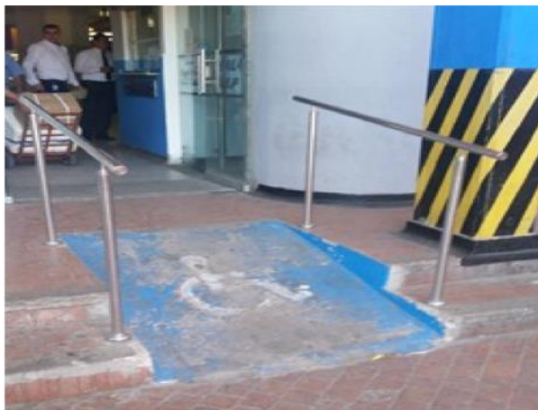
Fotografía 40 Rampa para accesibilidad
