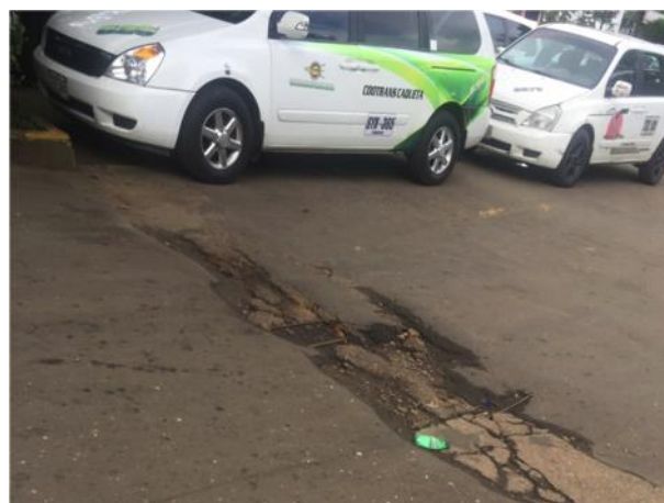
Fotografía 100 Vías Patio Operativo
