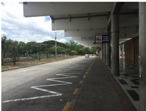
Fotografía 251 Plataforma de Descenso
