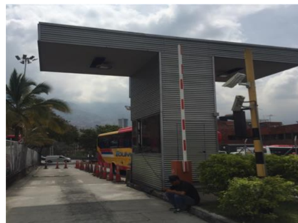
Fotografía 30 Control de acceso vehiculos
