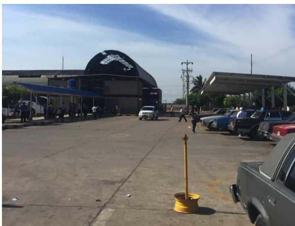
Fotografía 150 Plataforma de Descenso
