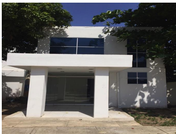
Fotografía 42 Sala de Conductores
