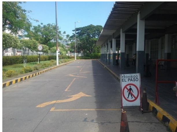
Fotografía 142 Plataforma de Descenso
