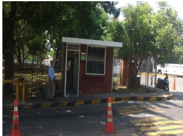
Fotografía 144 Caseta de Control
